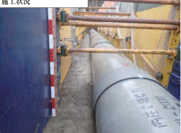
支線水路工事 (6の11) 施工状況
