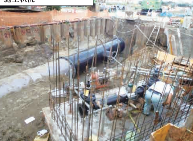
支線水路工事 (1の1) 施工状況
