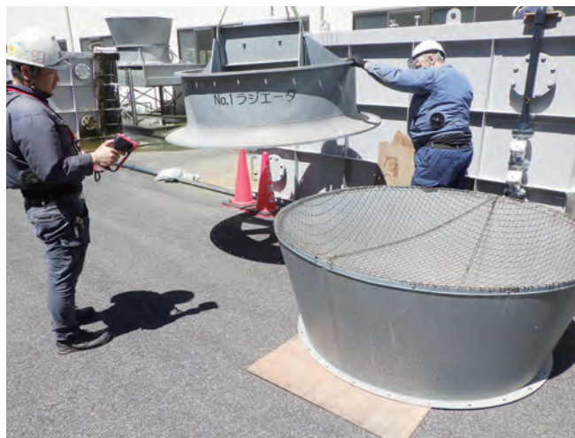
ラジエータの修繕工事 (第3揚水機場)
