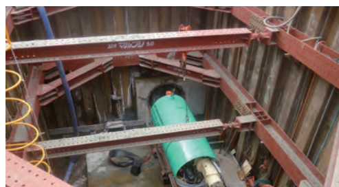
管の布設状況(推進工事)
