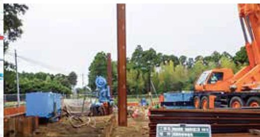
「両総茂原南地区」分土工の施工状況 (矢板打設 圧入工法)
