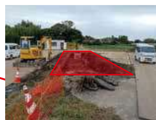
②「両総茂原南地区」支線用水路工事(4の4) 定流量弁室工の施工状況(開削中)
